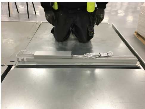
Align Luminaire
