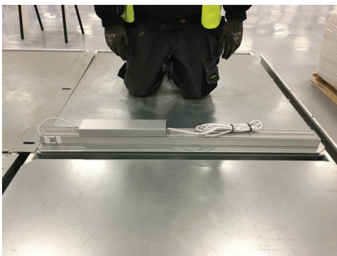
Align Luminaire
